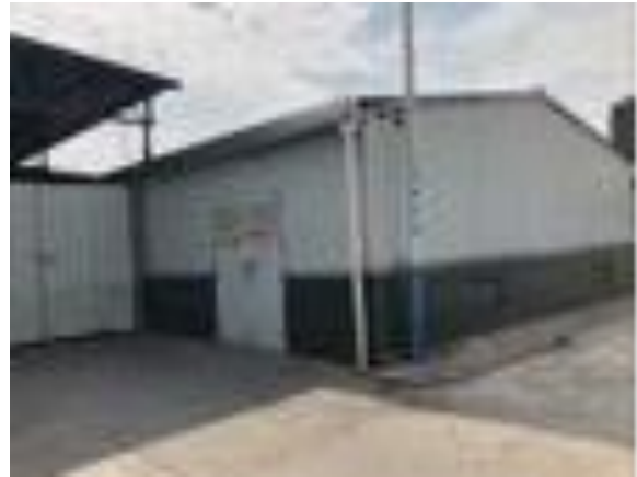
现有危废暂存间
