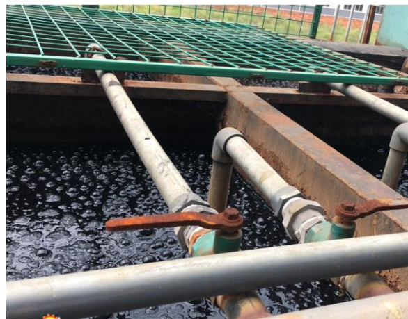
现有厂区污水处理站（运行中）
