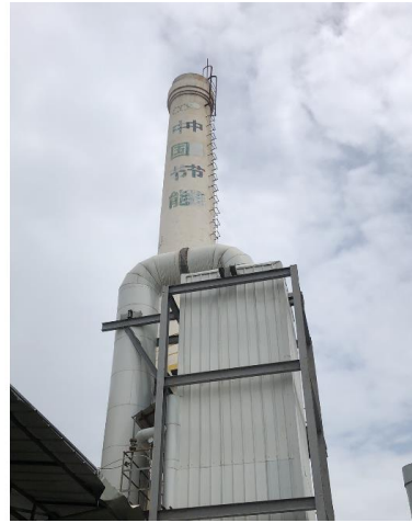
玻璃炉窑废气排气筒
