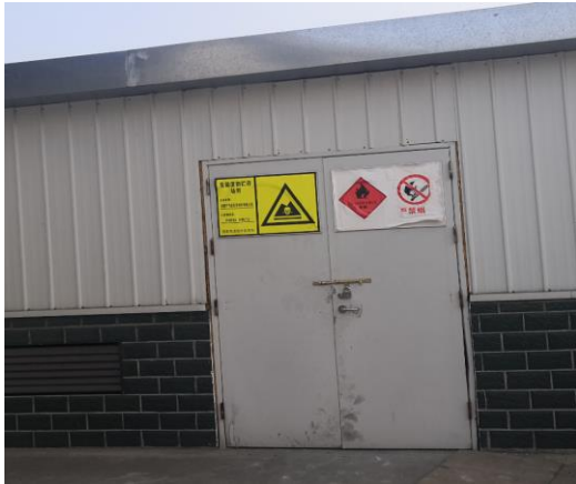
现有危废暂存间
