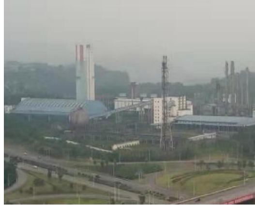
齐鲁化工（正在拆迁）
